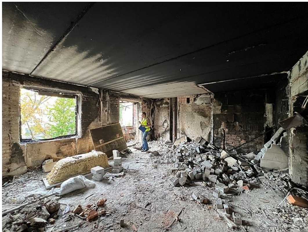
Рис. 1. Сліди пожежі ззовні та всередині будинку
